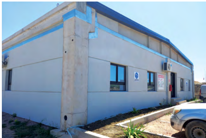
2 BASES DE VIE PONT BIZERTE / (Charpente béton - 500 m2)
