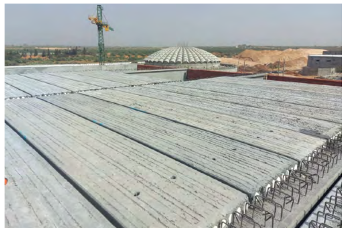
STATION DE TRAITEMENT DES EAUX KALAA-KBIRA SOUSSE / (Poutre préfabriquée+dalle alvéolée- 2 500 m 2 )
