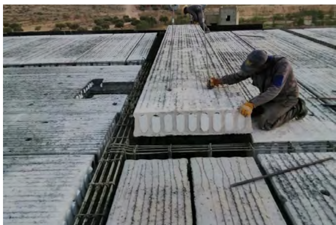
ECOLE FRANÇAISE DE SOUSSE (DALLE ALVÉOLÉE)
