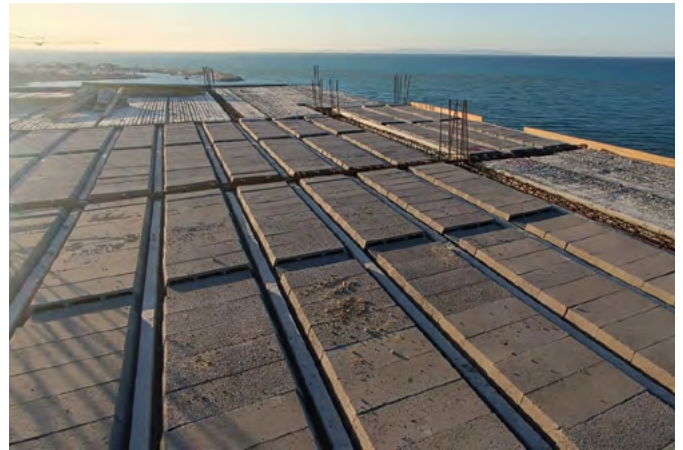
STATION DE TRAITEMENT DES EAUX KALAA-KBIRA SOUSSE / (Poutre préfabriquée+dalle alvéolée- 2 500 m 2 )
