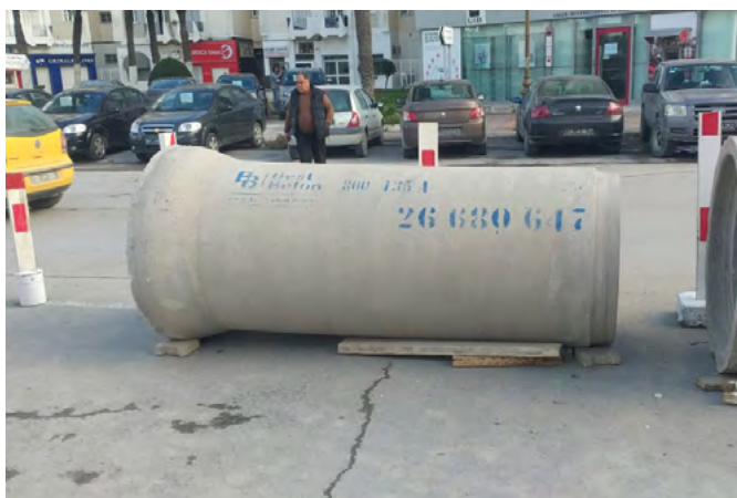
RÉNOVATION RÉSEAU PLUVIAL LA GOULETTE TUNIS (TUYAUX)
